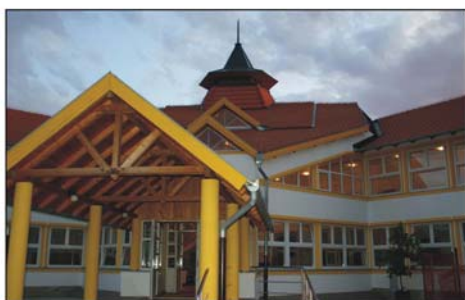
Az iskola épülete
